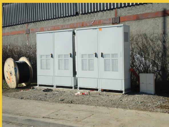
Tous les travaux préparatoires de génie civil ont commencé en octobre 2014 : construction d'une plateforme rue des Condamines destinée à recevoir les armoires du NRA-MED, pose des fourreaux nécessaires pour l'alimentation électrique et la connexion de la fibre optique amenée depuis St-Martin d'Hères.
