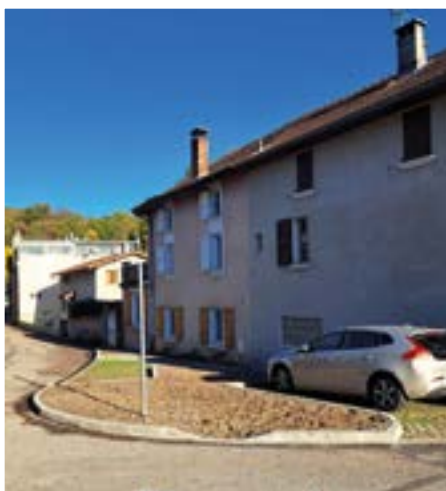
Places PMR et stationnement
