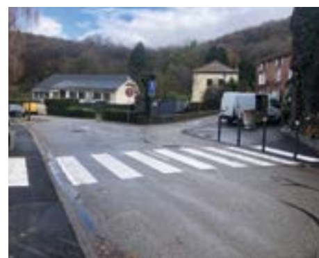
Passage piéton, sécurisation des piétons
